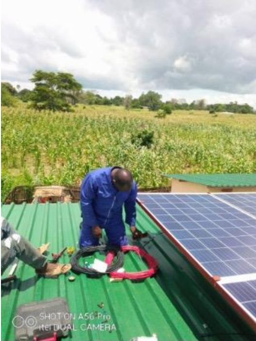
Figuur 2: Zonnepanelen, solarpomp
